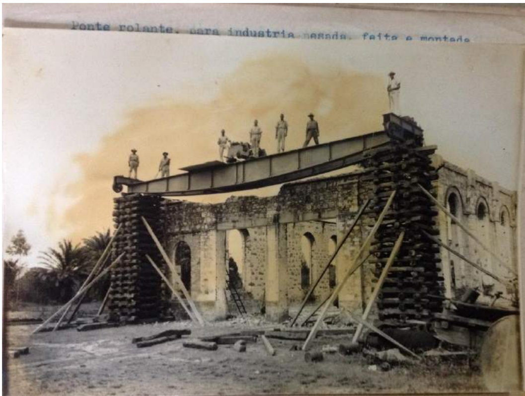
Imagem 7: "Ponte rolante para indústria pesada, feita e montada". Fonte: Fotografia da Tarzan retirada do catálogo cedido por Raimundo Artur. Data e autor desconhecidos.
